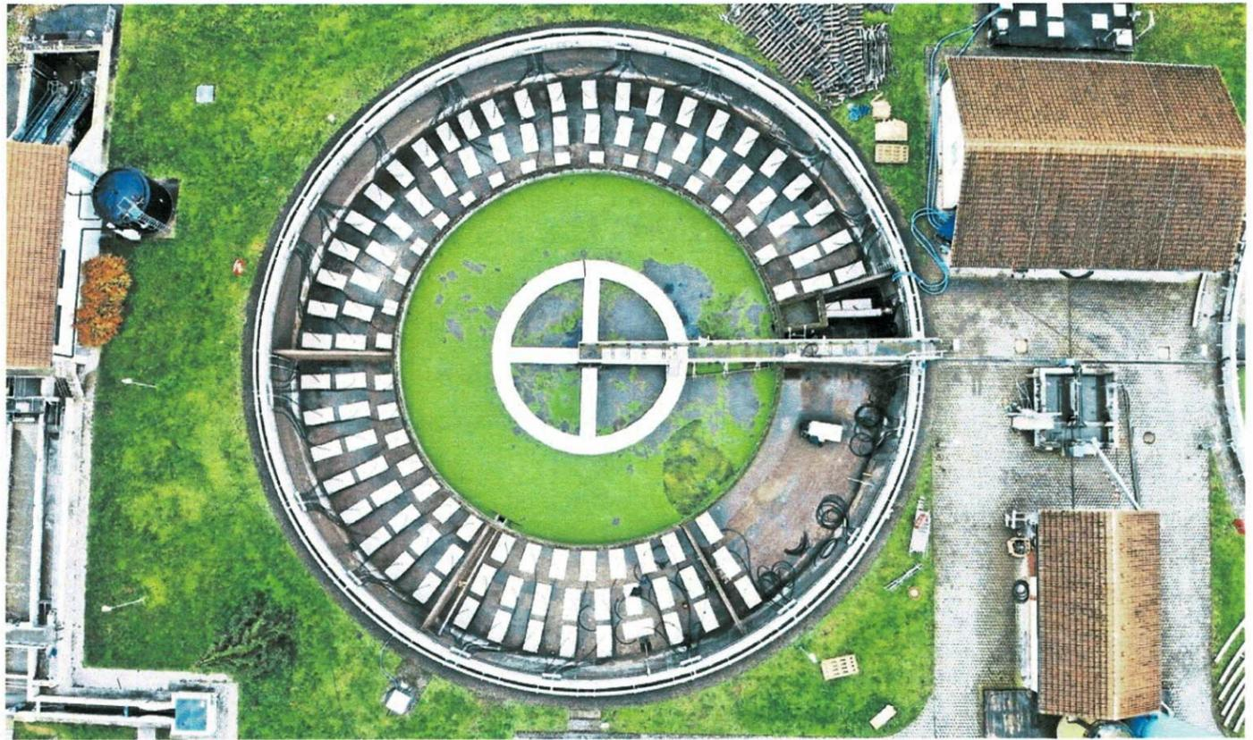
Die neuen Belüfterplatten werden auf dem Boden eines der beiden Belebungsbecken in der Abwasseranlage Niedermittlau installiert.
