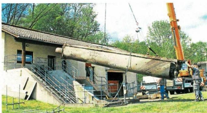
Die alte Schneckenpumpe 1 wird im Klärwerk Neuenhaßlau ausgetauscht.
